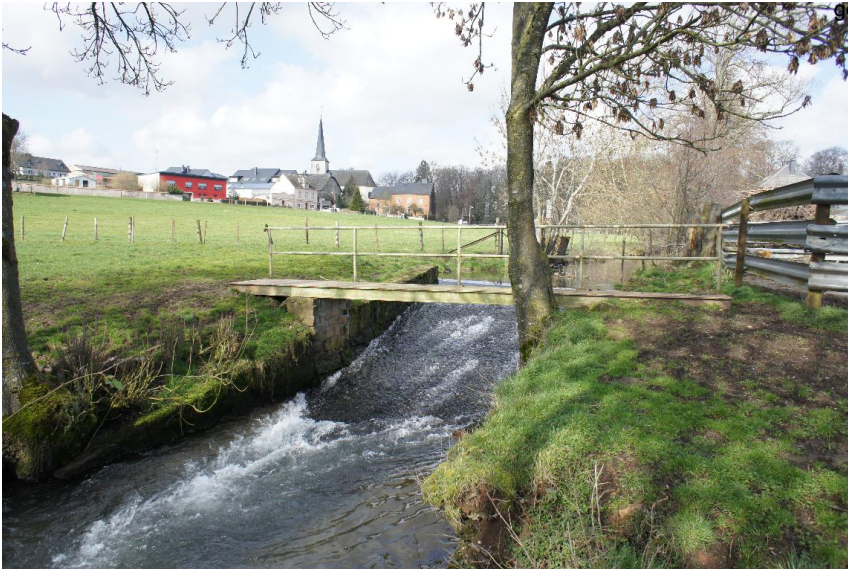
Raue Rampe - Durchlass; Ufer unterbrochen
