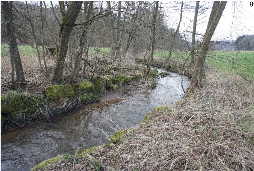
Uferbefestigung durch Steinblocke
