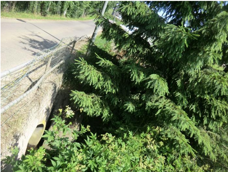
Durchlass; Ufer unterbrochen
