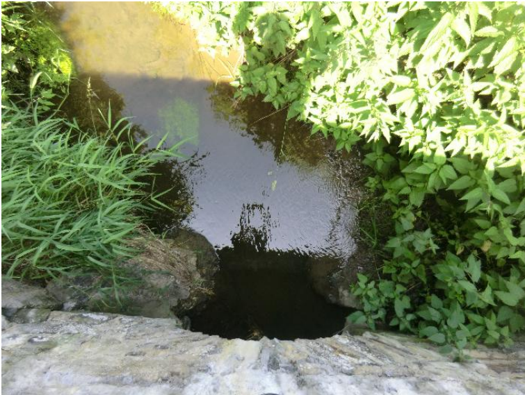
Durchlass; Ufer unterbrochen
