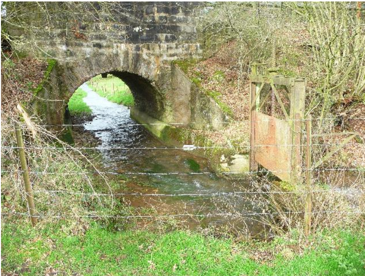
Durchlass; Ufer unterbrochen
