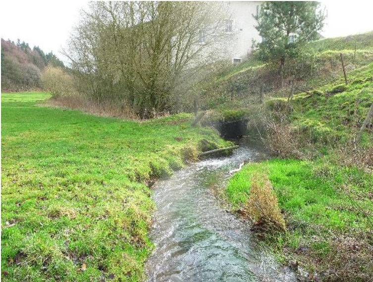
Durchlass; Ufer unterbrochen
