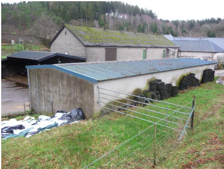
verroht bzw. ueberdeckt
