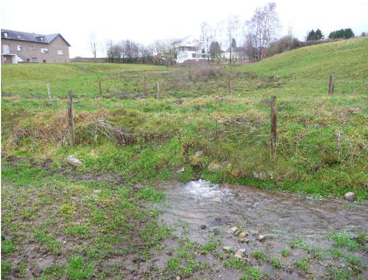
Durchlass; Lauf verengt
