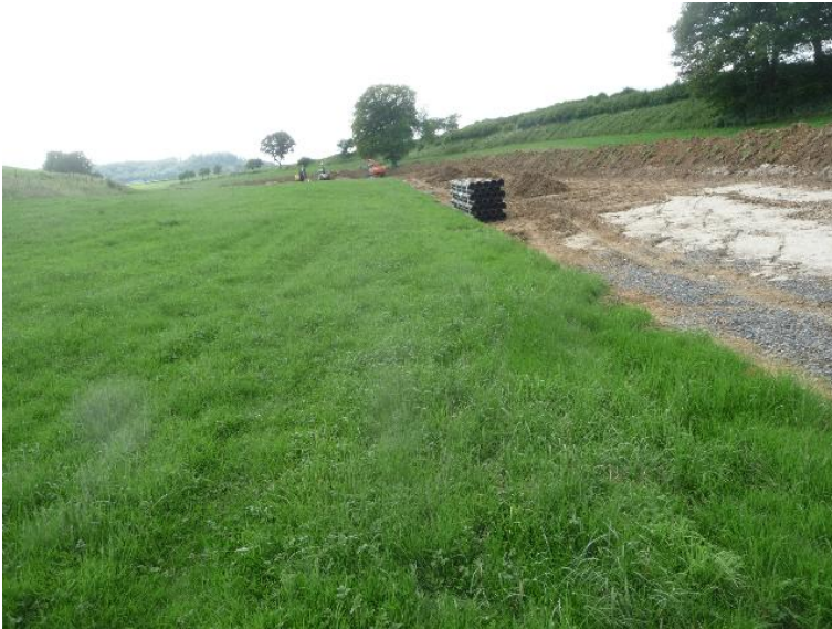
verrohrt bzw. ueberdeckt
