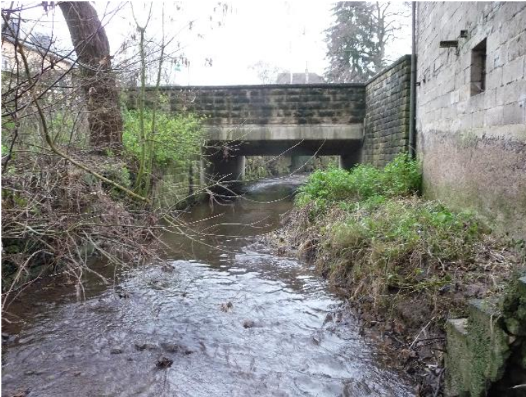
Durchlass; Ufer unterbrochen
