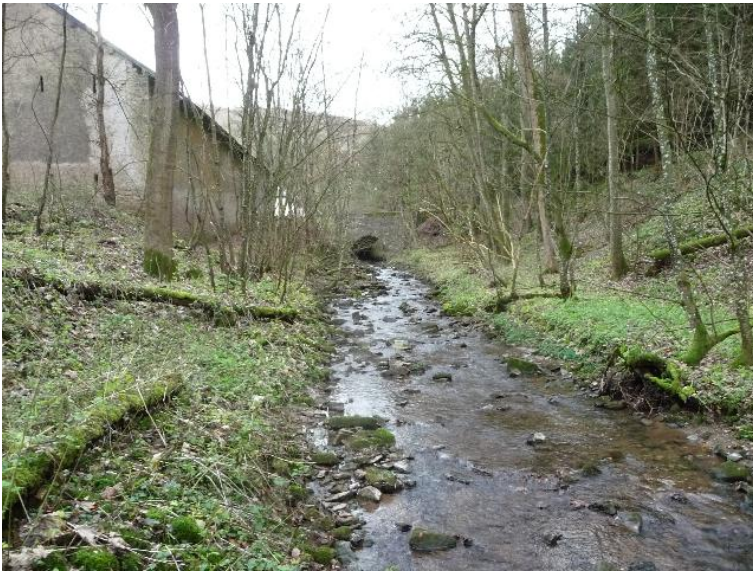
Durchlass; Ufer unterbrochen
