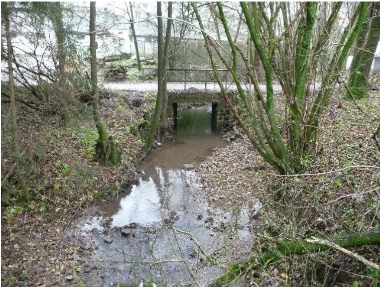
Durchlass; Ufer unterbrochen
