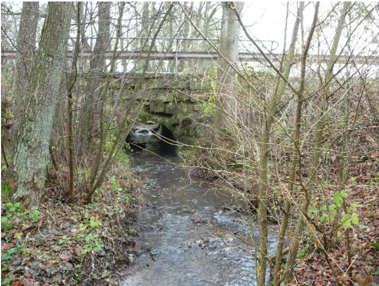
Durchlass; Ufer unterbrochen
