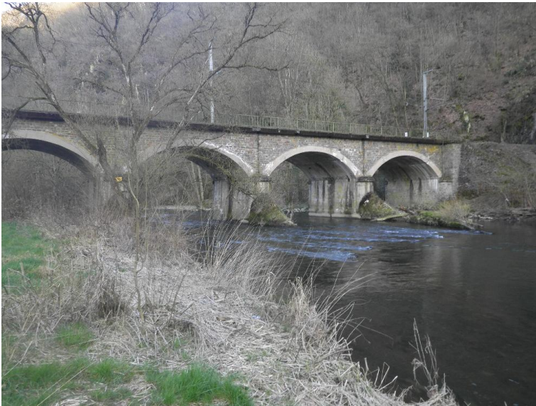
Durchlass; Ufer unterbrochen
