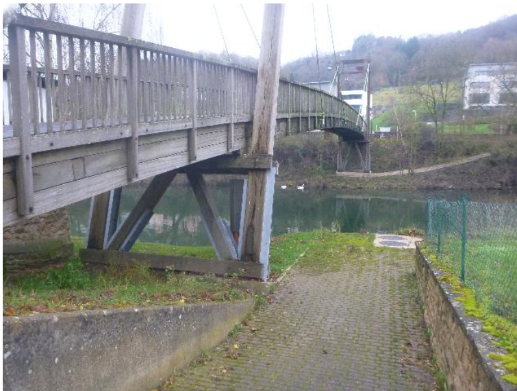
Durchlass; nicht strukturschädlich
