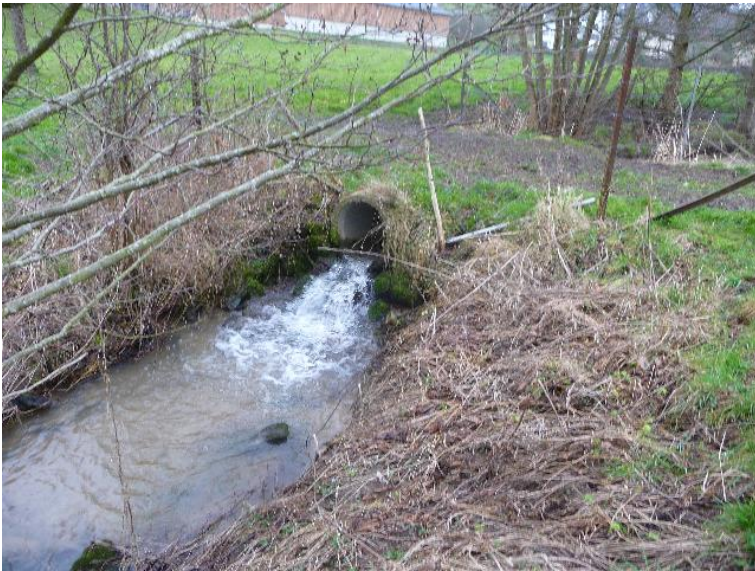
Durchlass; Ufer unterbrochen
