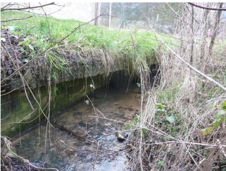
Durchlass; Ufer unterbrochen
