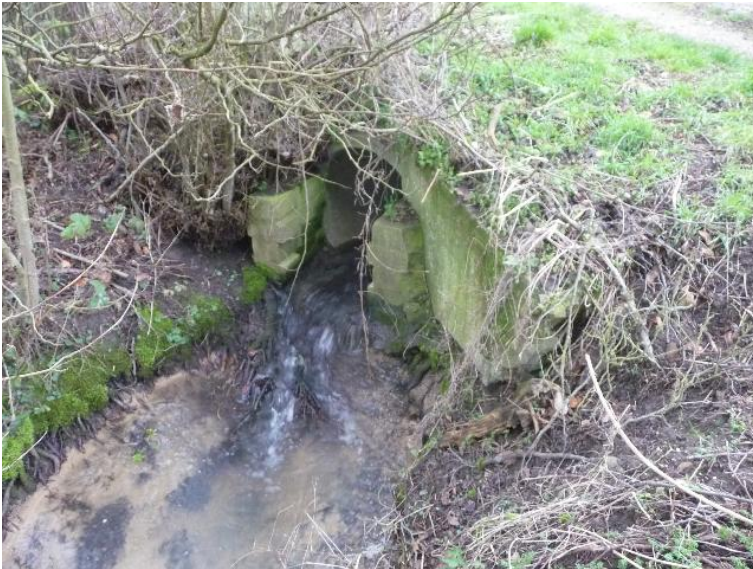
Durchlass; Ufer unterbrochen
