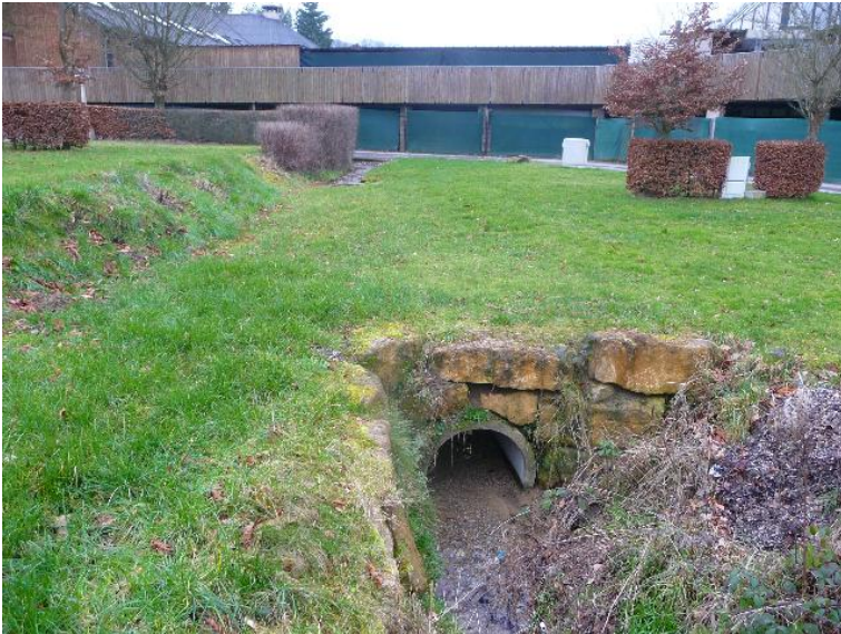
Durchlass; Ufer unterbrochen
