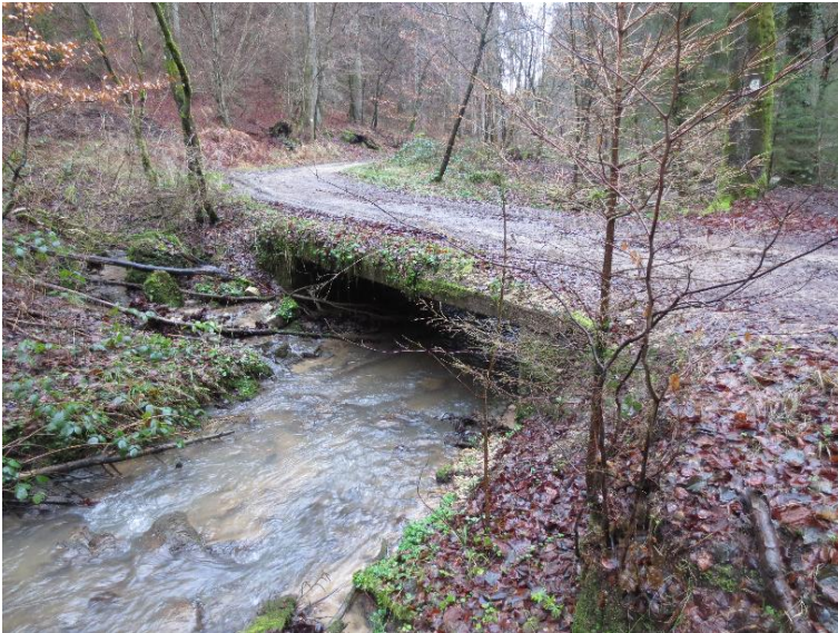
Durchlass; Ufer unterbrochen
