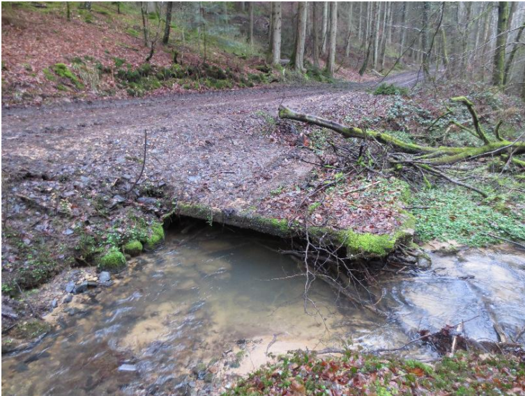
Durchlass; nicht strukturschädlich
