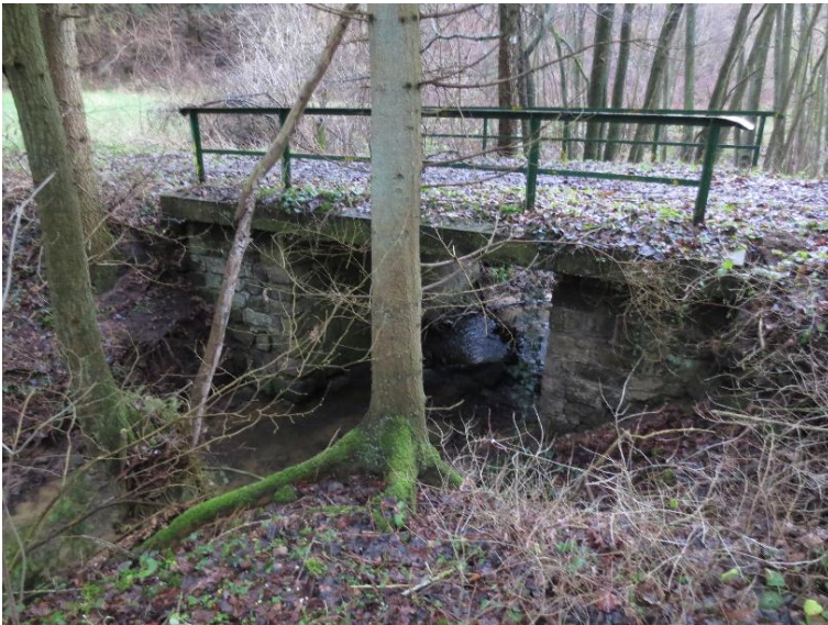
Durchlass; Ufer unterbrochen
