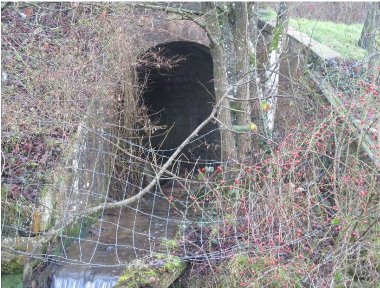
Durchlass; Ufer unterbrochen
