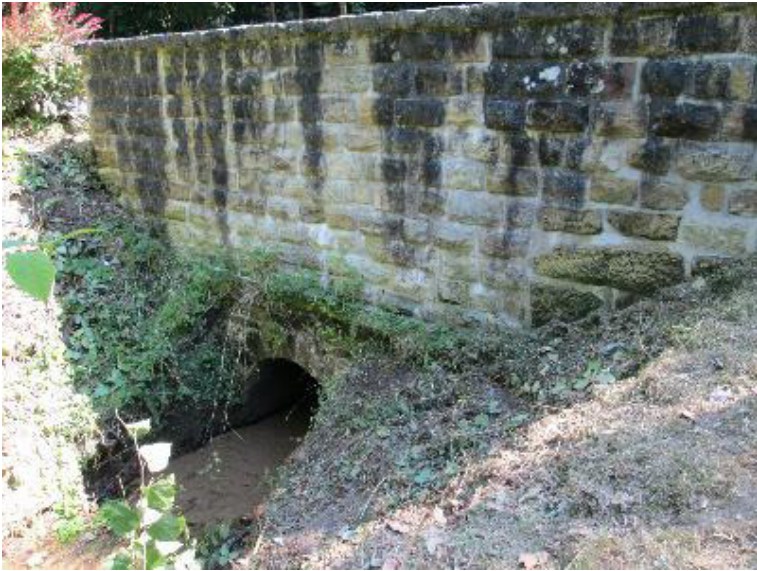
Durchlass; Ufer unterbrochen
