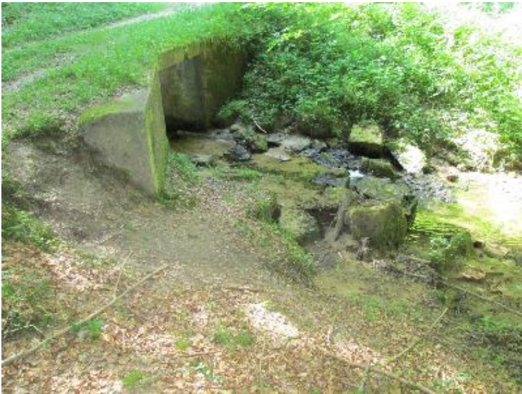
Raue Rampe - Durchlass; Ufer unterbrochen
