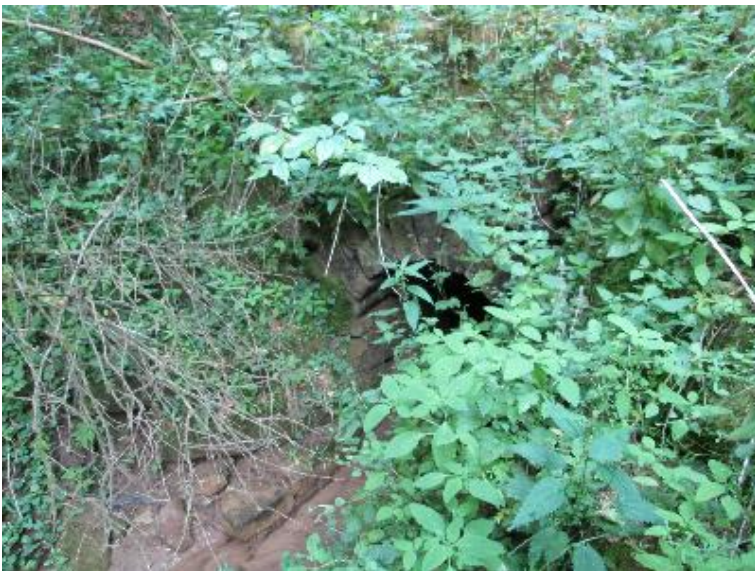
Durchlass; Ufer unterbrochen
