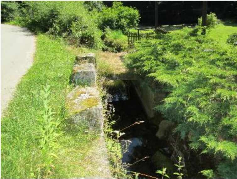
Durchlass; Ufer unterbrochen
