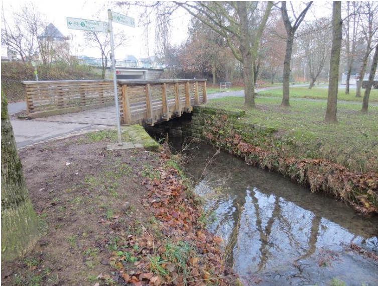
Durchlass; Ufer unterbrochen
