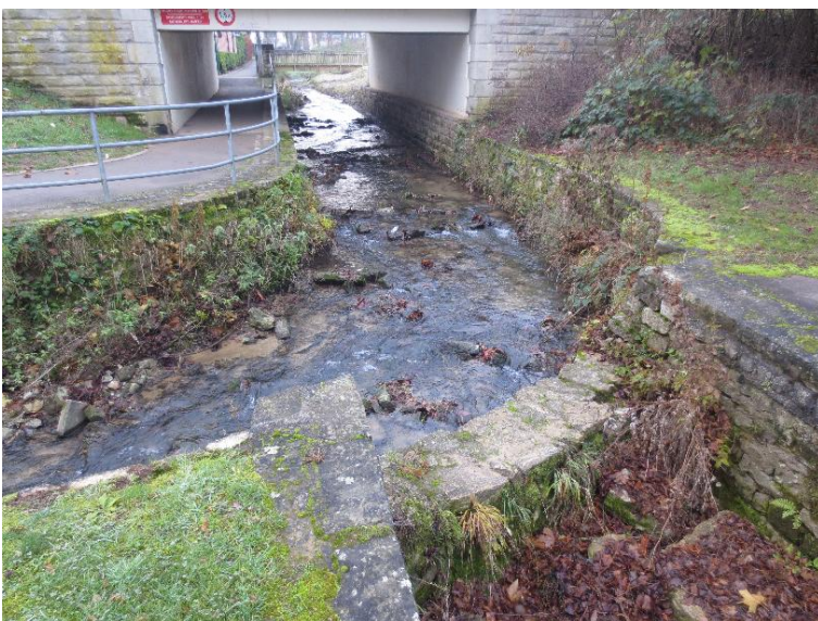
Durchlass; Ufer unterbrochen
