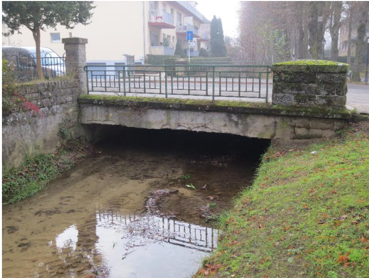
Durchlass; Ufer unterbrochen
