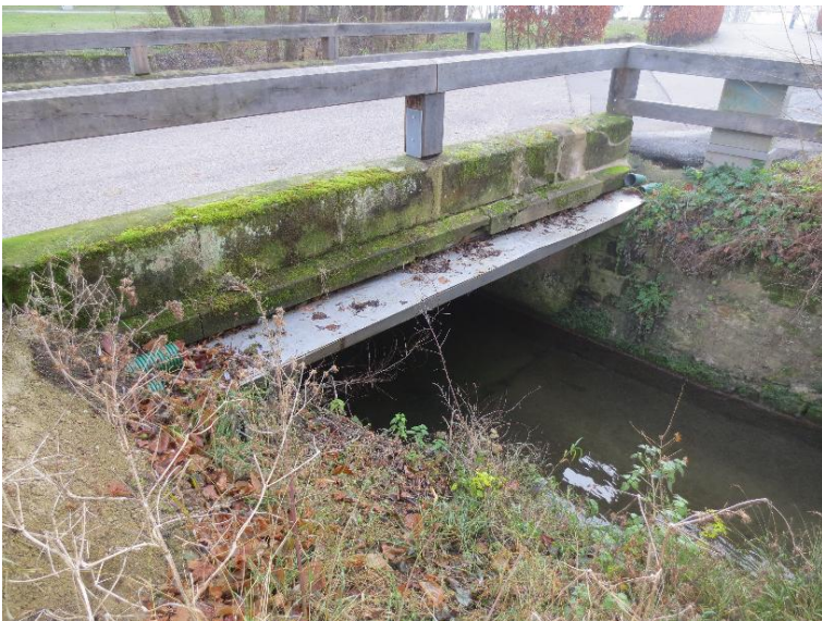
Durchlass; Ufer unterbrochen
