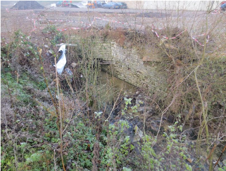
verrohrt bzw. ueberdeckt
