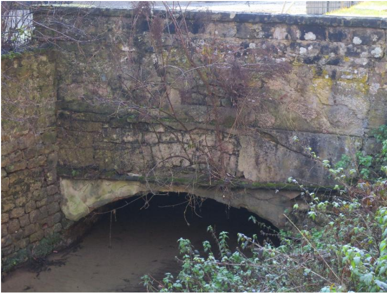
Durchlass; Ufer unterbrochen
