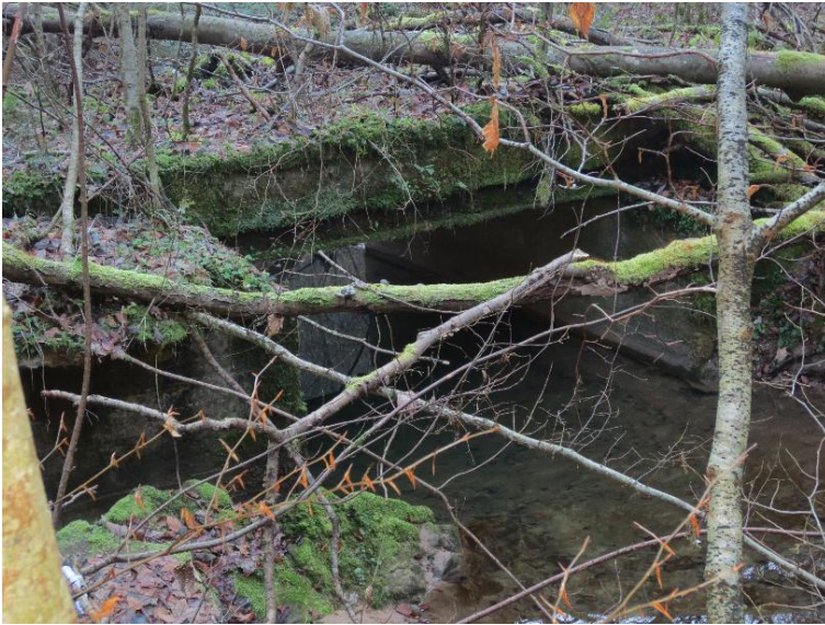
Durchlass; Ufer unterbrochen
