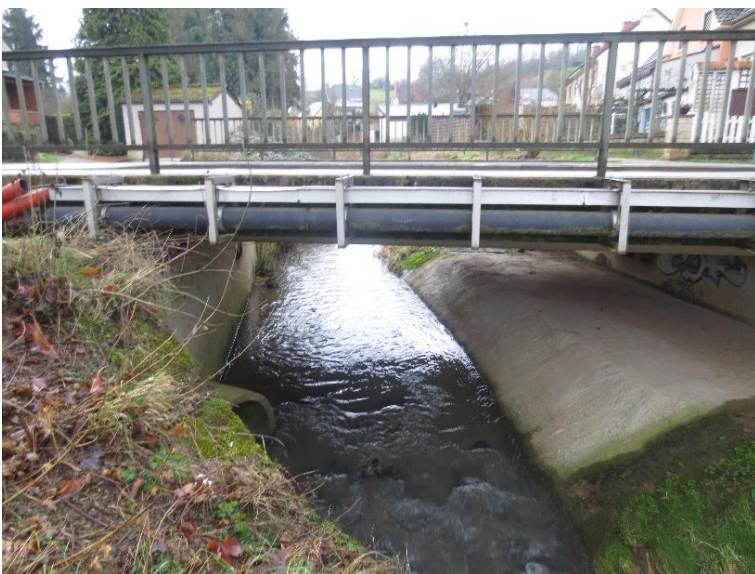
Durchlass; Ufer unterbrochen
