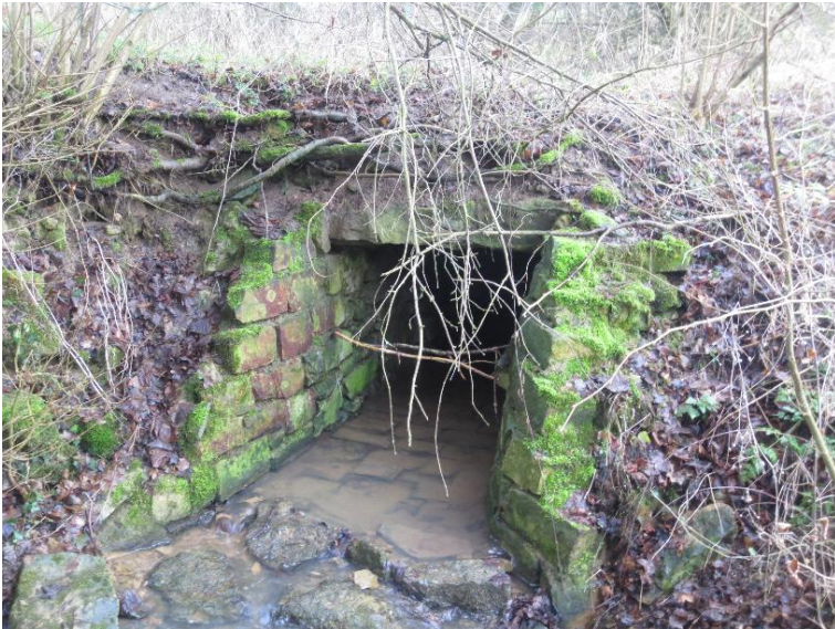
Durchlass; Ufer unterbrochen
