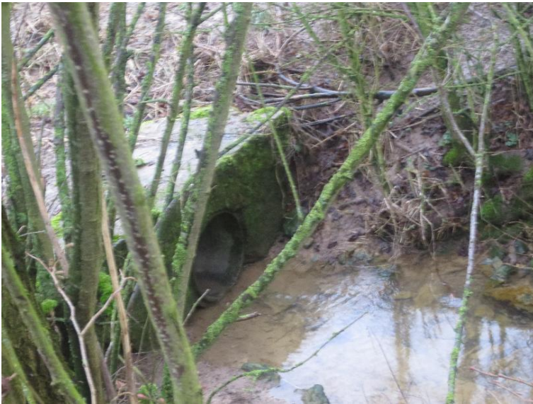
verrohrt bzw. ueberdeckt
