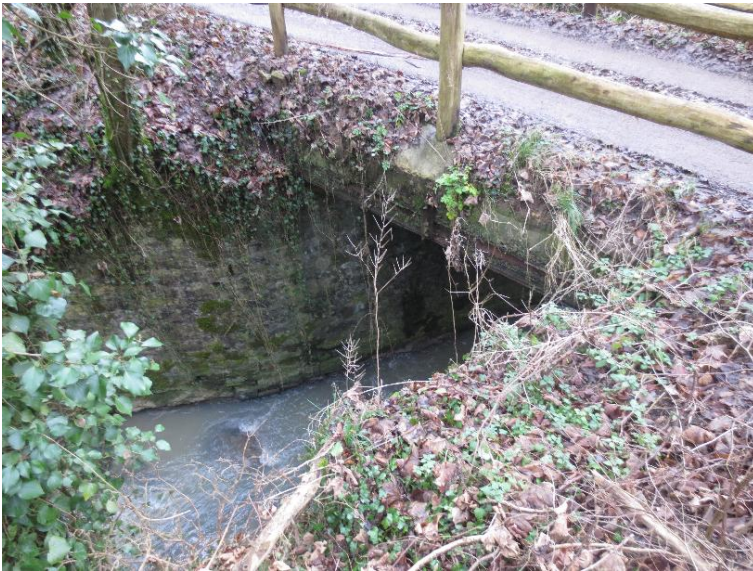
Durchlass; Ufer unterbrochen
