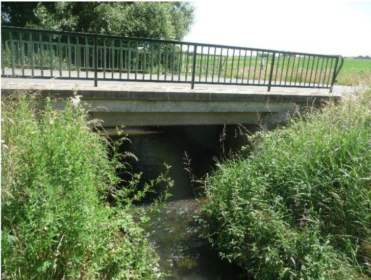
Durchlass; Ufer unterbrochen
