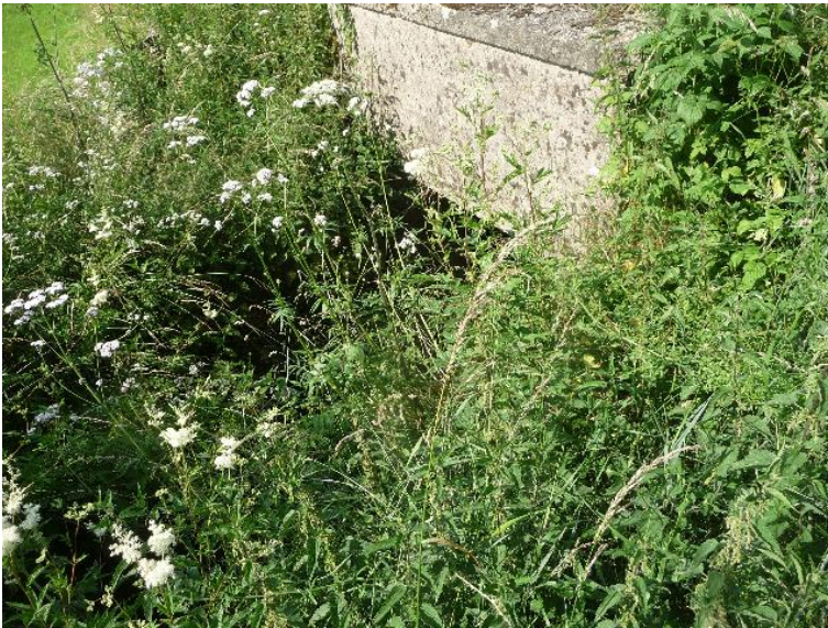
Durchlass; Ufer unterbrochen
