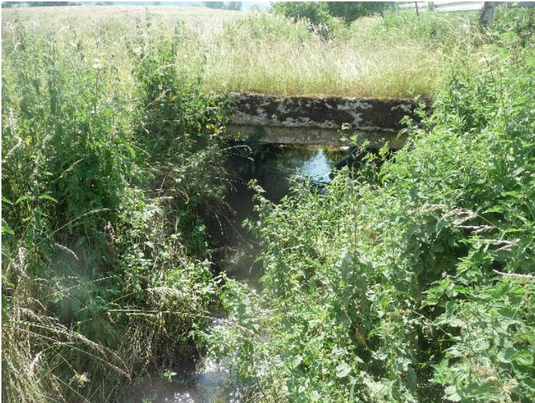
Durchlass; Ufer unterbrochen
