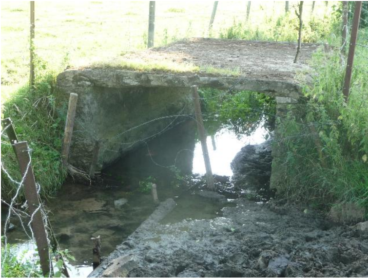
Durchlass; Ufer unterbrochen
