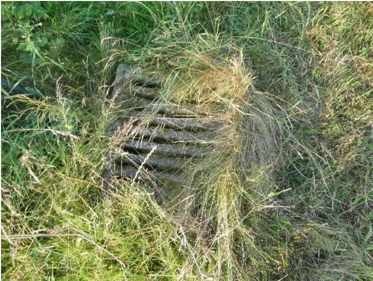
verrohrt bzw. ueberdeckt
