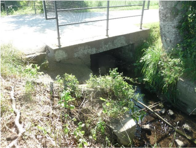
Durchlass; Ufer unterbrochen
