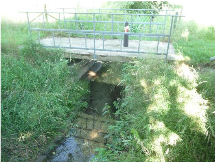
Durchlass; Ufer unterbrochen
