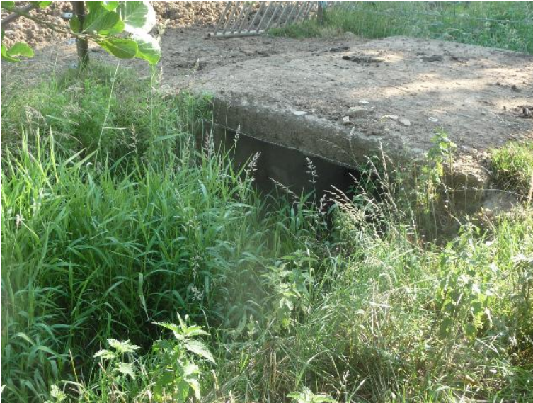
Durchlass; Ufer unterbrochen
