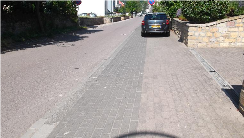
verrohrt bzw. ueberdeckt
