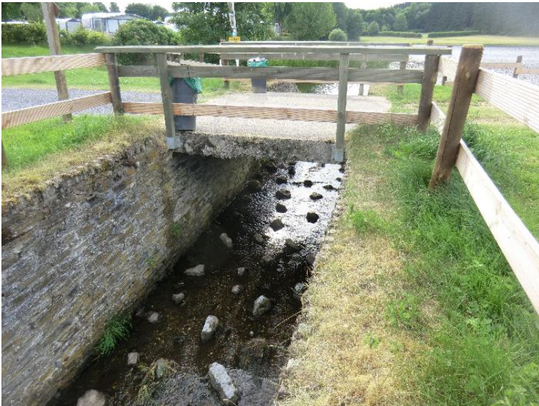
Durchlass; Ufer unterbrochen
