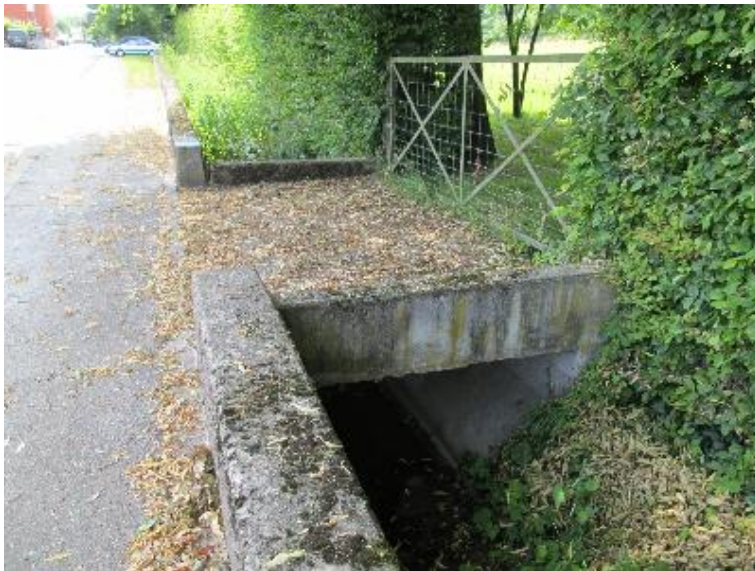
Durchlass; Ufer unterbrochen
