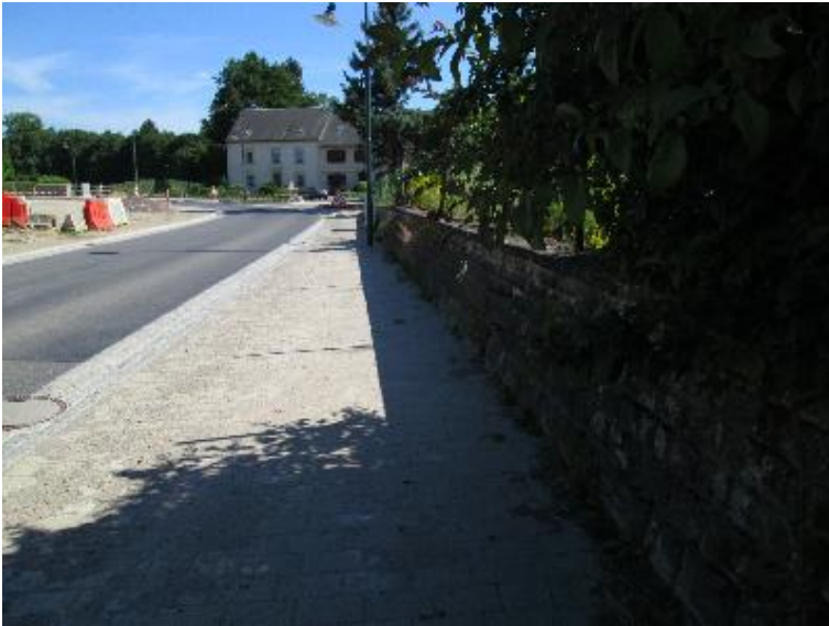
verrohrt bzw. ueberdeckt
