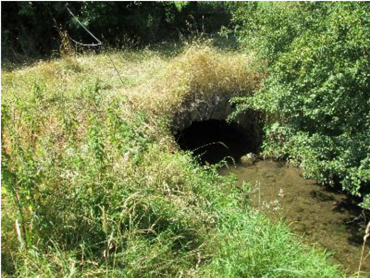
Durchlass; Ufer unterbrochen
