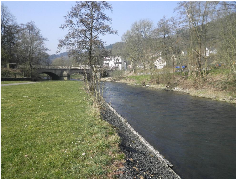
Durchlass; Ufer unterbrochen
